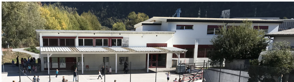
Ci-dessus, la partie gauche du bâtiment, toit et façade, sont à rénover
